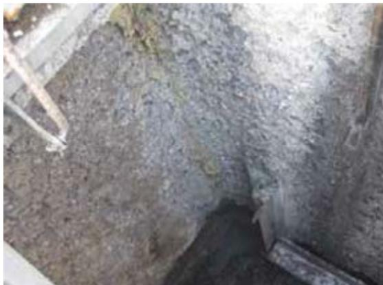
住家和部分產業的廢水含有有機物，若未維持低溫便會在短時間內腐敗和分解，這是由於微生物攝食與分解有機物所造成，並排出代謝物。根據環境的氧氣含量，污水管的微生物主要產生兩種代謝物。一般狀況下他們大都排放硫酸鹽類，但若水流很緩慢，水中的氧氣便會消耗殆盡，而迫使微生物產生硫化氫。
